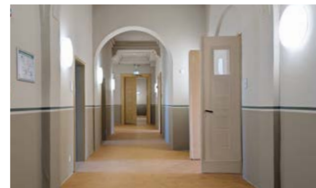
Ein Blick in die instand gesetzten Flurbereiche nach Abschluss der Sanierungsarbeiten.
