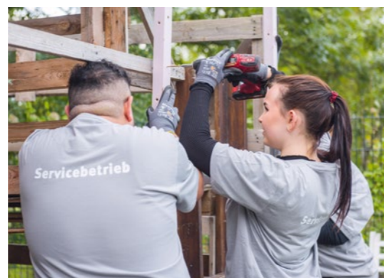
Unzählige Schrauben wurden ins Holz eingedreht.
