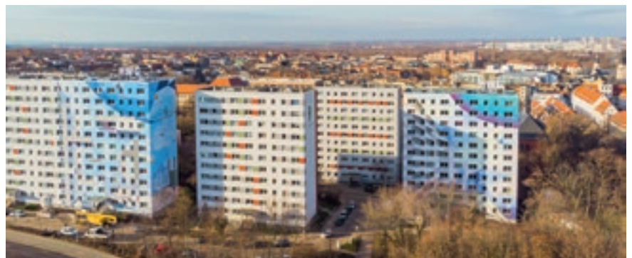
Blick auf das Quartier. Hervorstechend die beiden HWG-Häuser in der Voßstraße, deren Fassaden bereits von der Freiraumgalerie gestaltet wurden.
