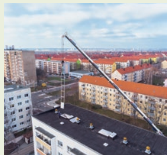
Arbeiten an den künftigen Aufzügen in der Murmanner Straße.
