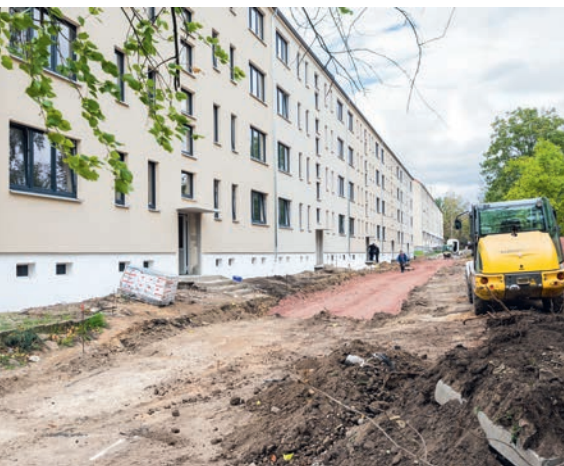
Letzte Arbeiten am zweiten Bauabschnitt.
