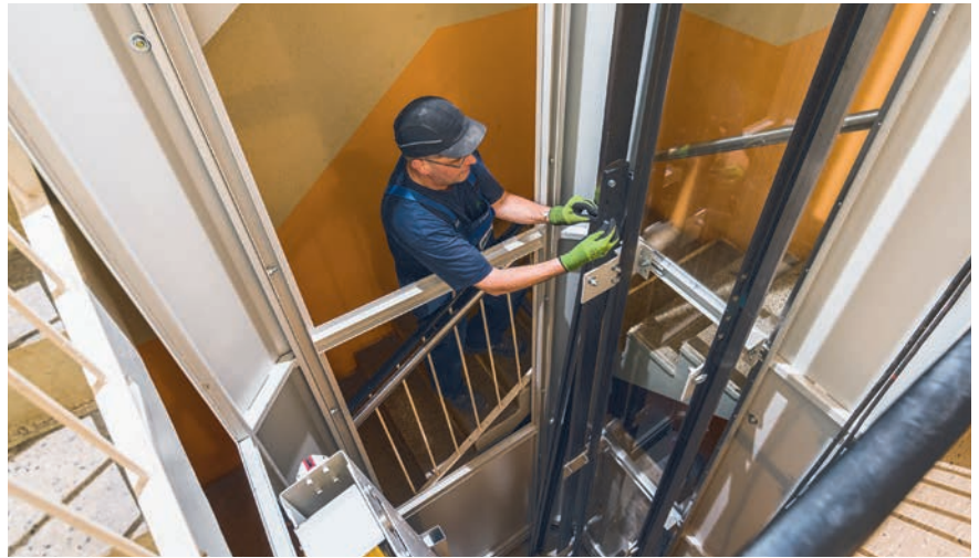
Aufzugseinbau in der Murmanker Straße 18 a-d.
